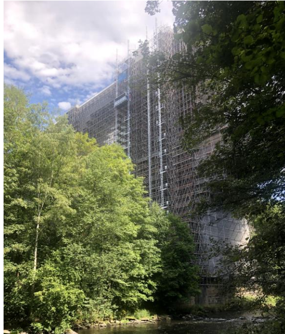
Foto: eingerüstete Elstertalbrücke, Günther Hendel
